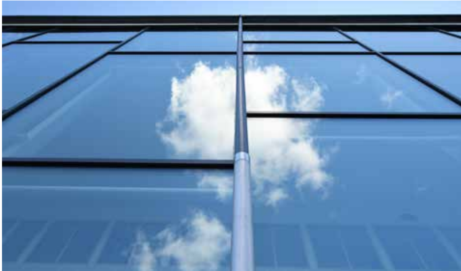
På Nyboda skola har stuprörens placering på ett medvetet sätt anpassats till de stora glaspartiernas indelning. Putsningen av fönstren sker med skylift.
